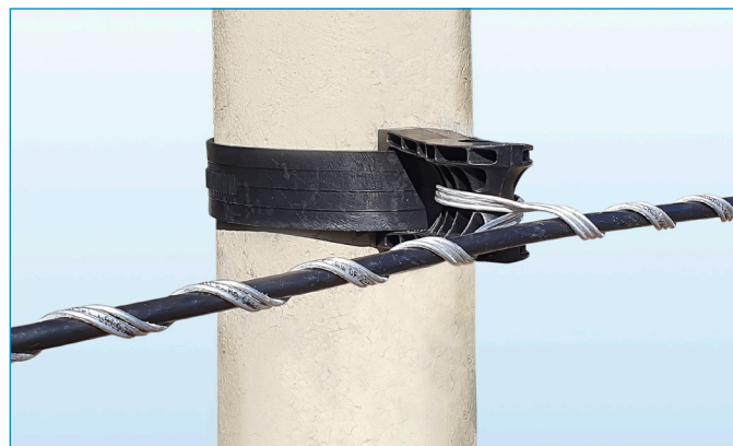
Suspensão com laço preformado
