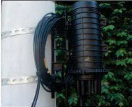
7.1.1. Instalación en poste.
