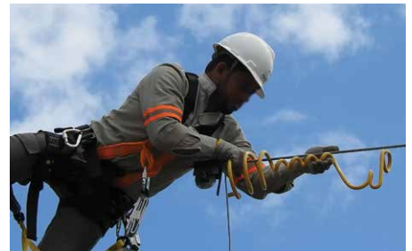
A primeira instalação do novo PPPC foi realizada pela empresa IE Garanhuns, na Subestação Pau Ferro 500-230 kV, em Recife - PE.
