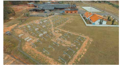
Domus Solar instala Estruturas Bipostes PLP
