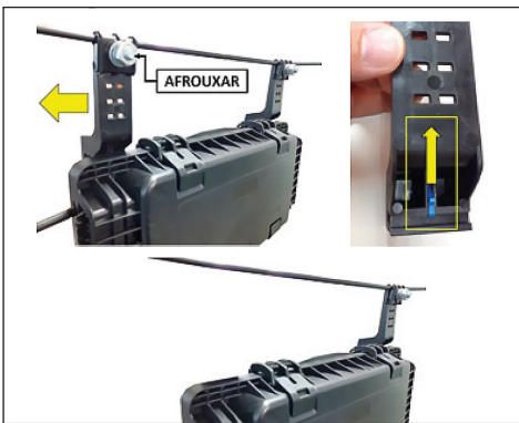
4.5.3 Para bajar la caja, afloje el conjunto prensacables de uno de los soportes poliméricos, levante la traba de seguridad y, sosteniendo la caja, deslice este soporte aflojado en la dirección opuesta a la de montaje. Entonces levante la traba del otro soporte, manteniéndola fija en el cable de acero, y desenganche la caja del soporte para que quede libre para bajar.
