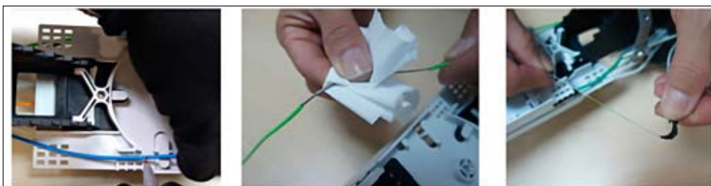
Marcado, Limpieza y Acabado de la Fibra Óptica.
