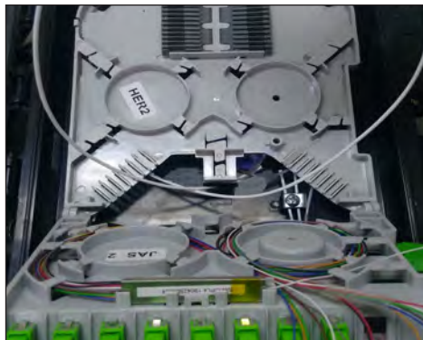
5.15. Montar el conjunto de bandejas basculantes en el lugar adecuado y pasar la reserva de la sangría por la abertura central de las dos bandejas.
