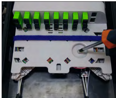
6.7. Utilizar la cinta de velcro y el tornillo 3,9 x 22 para trabar el conjunto de bandejas basculantes.
