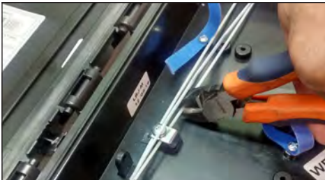
5.11. Cortar el elemento de tracción.
