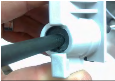
5.8. Posicionar la goma de sello correctamente y montar el soporte bipartido para el sellado del cable óptico.
