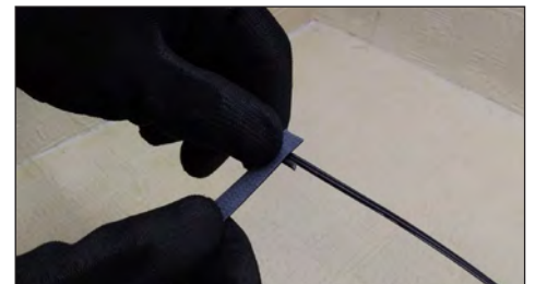
7.4. Se recomienda realizar el acabado del drop óptico con cinta autosoldable o aislante, para evitar la laceración.
