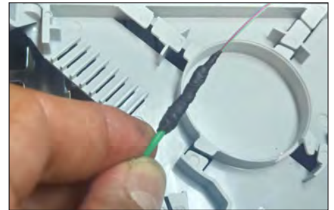
5.18. La protección de la cinta autosoldable será de 20 mm para el tubo loose y 10 mm en la fibra óptica.
