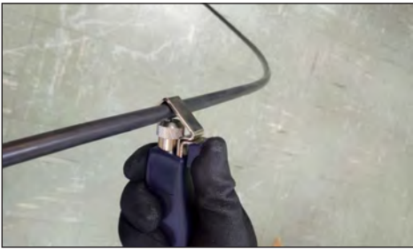
6.1. Decapar el cable óptico de derivación con 1,5 m de longitud.
