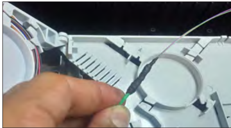
5.14. NOTA 1: La protección de la cinta autosoldable será de 20 mm para el tubo Loose y 10 mm. En la fibra óptica.
