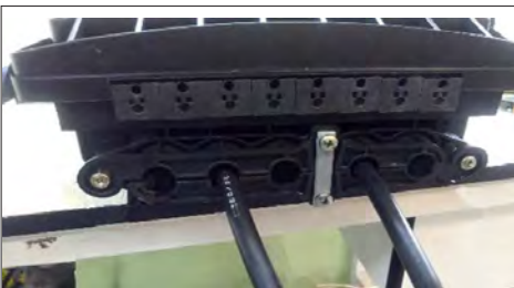
5.10. Finalizar el sellado del CFOA de alimentación con el soporte bipartido del grommet, chapa de traba y tornillo de cabeza redonda Phillips M5 x 30.
