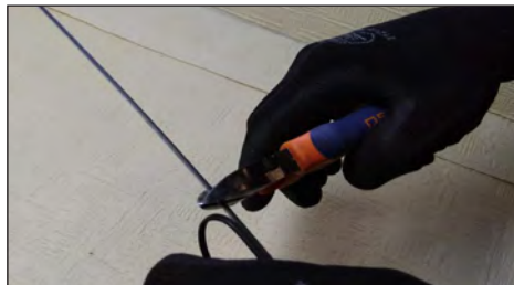
7.3. Cortar el alambre de sustentación en aproximadamente 400 mm de longitud.
