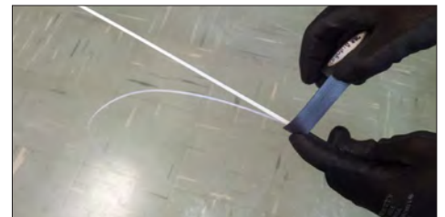
6.1. Preparar el CFOA con 1,5 metros de longitud para la derivación.
