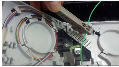
5.12. Adelantar, cortar alrededor y decapar el tubo Loose.
