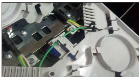
5.16. Utilizar abrazaderas plásticas para la fijación del tubo Loose en la bandeja de la caja.
