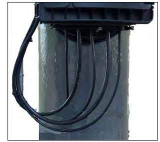
8.5. Alinear los cables para el alojamiento en el soporte de Reserva Técnica.
