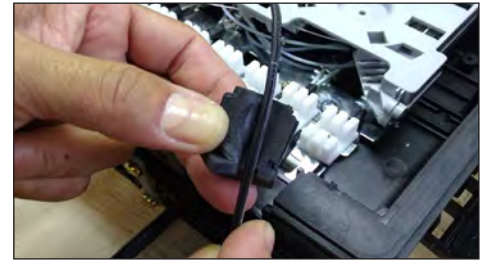
7.6. Remover la goma de sello del drop óptico (bipartida) y encajar el drop en su cavidad.
