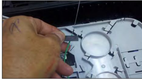
5.13. Realizar la protección del tubo Loose y fibra óptica con cinta autosoldable de 30 mm.
