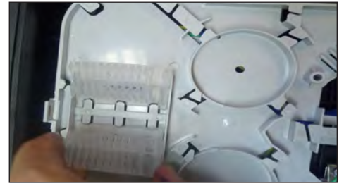
5.17. Encajar las cunas de alojamiento de los protectores de empalme ópticos (tubetes).
