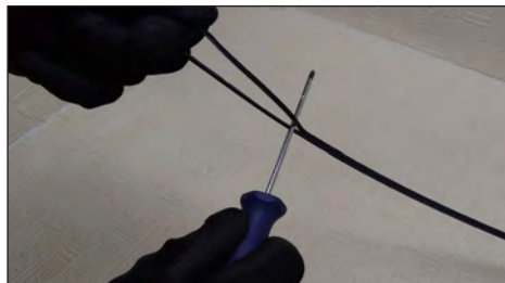
7.2. Separar el alambre de sustentación del Drop Óptico.
