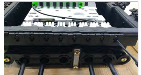
7.8. Ejemplo de conexión del drop óptico finalizado.
