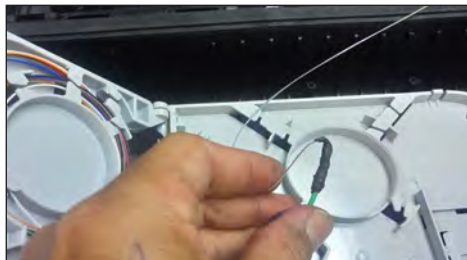
5.15. NOTA 2: Este procedimiento es aplicado para la protección de la fibra óptica para evitar la posible rotura a la salida del tubo Loose ("pié de la fibra").
