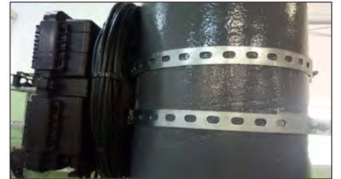
8.6. Después del alojamiento de los cables, utilizar 2 abrazaderas plásticas T120R de cada lado, para amarre de los cables.
