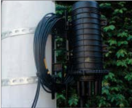
7.1.1. Instalación en poste.
