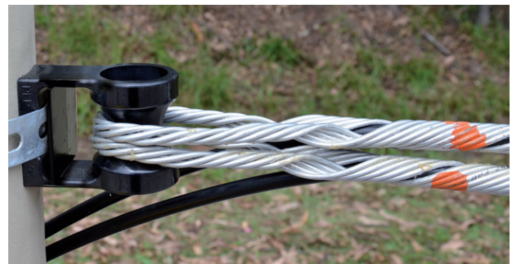
Anclaje con Retenciones Preformadas
