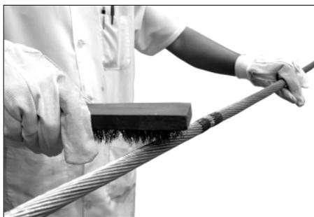
**2.** Proceda a limpeza do cabo. Utilize uma escova de aço para escovar o cabo em toda extensão onde será aplicada a Emenda Preformada.
