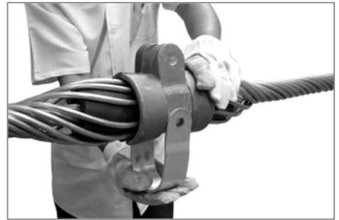
**12.** Insira a abraçadeira de alumínio envolvendo o conjunto. Afaste as orelhas das sapatas e posicione novamente a fim de facilitar o alinhamento e colocação do parafuso.
