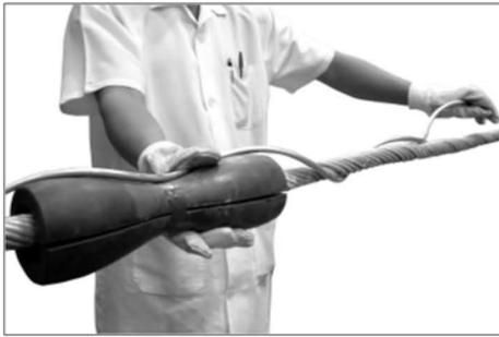
**8.** Inicie a aplicação das varetas colocando a marca central das varetas sobre o meio dos coxins. Mantendo a vareta em posição paralela ao cabo, inicie o giro de uma das extremidades em torno do cabo, conforme indicado. Em seguida, aplique as outras varetas.
