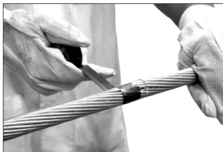
**1.** Aplique uma camada de fita isolante próximo aos tentos rompidos do cabo condutor a fim de evitar que os mesmos se separem.
