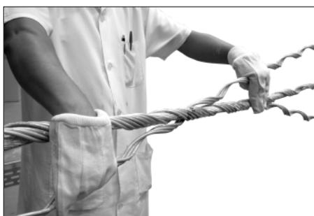
**5.** Faça coincidir as marcas centrais dos outros dois subconjuntos da Emenda e aplique-os sobre o cabo até faltarem duas ou três voltas de cada lado para o término da aplicação.
