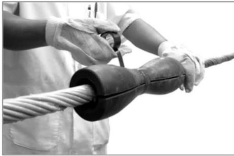
**7.** Sobre a marca central da Emenda Preformada aplique os coxins fixando as duas partes com uma camada de fita isolante.
