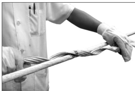
**4.** Escolha o subconjunto da Emenda que contém o maior número de varetas e aplique metade dele no cabo condutor, iniciando a aplicação a partir da marca central. Certifique-se de que a direção de encordoamento do cabo e do Preformado é a mesma.
