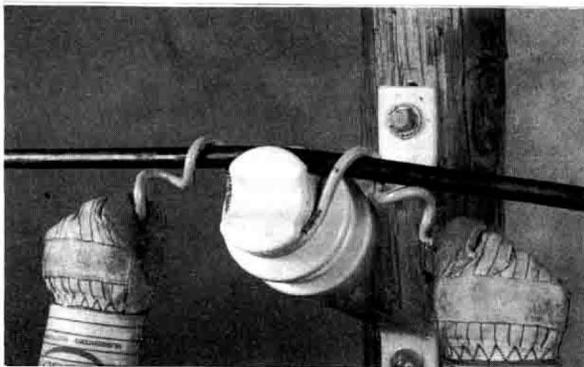
3. Dê uma volta no lado direito do Laço sobre o cabo. Então levante o lado esquerdo e dê uma volta completa em torno do cabo.
