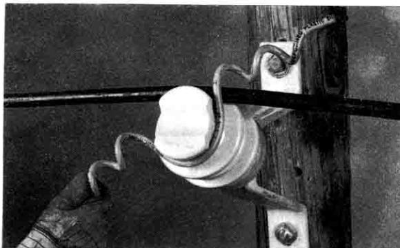
1. Coloque o cabo no pescoço do isolador, posicione o centro do Laço Plástico Lateral no lado oposto ao condutor, conforme mostrado.
