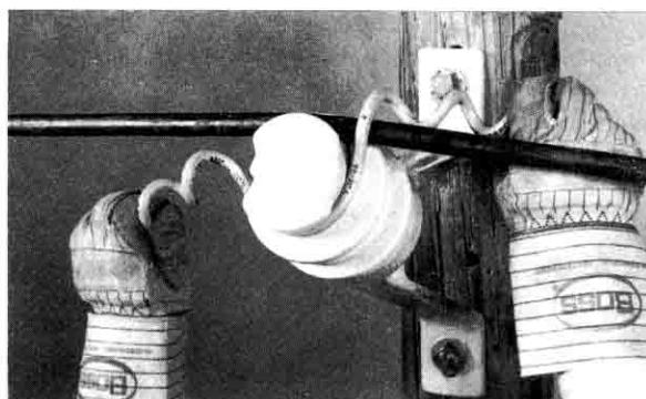
2. Coloque o lado direito do Laço por sobre o cabo, enrolando-o pela parte de trás, neste mesmo tempo coloque o lado esquerdo do Laço enrolando-o pela parte de baixo do cabo, conforme mostrado.
