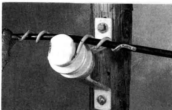
5. Pressionando levemente com o polegar, coloque as pontas do Laço para terminar a aplicação.
