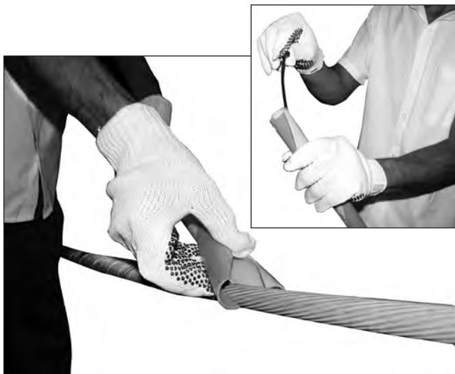
**1.** Retire a abraçadeira plástica e introduza as duas metades do Sinalizador de Estais sobre o cabo.
