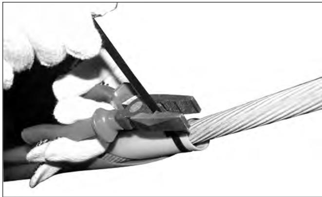
**5.** Corte o excesso da abraçadeira após a trava.
