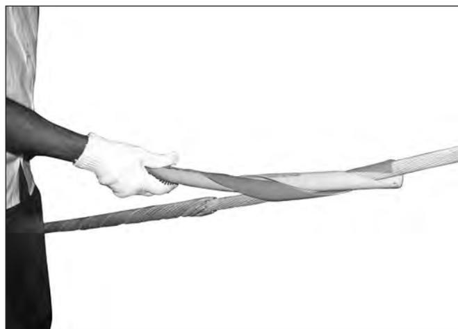
**2.** Inicie a aplicação pela parte superior, aplicando todo o Sinalizador de Estais com movimentos helicoidais. Certifique-se que o cabo de estais esteja no interior do Sinalizador.
