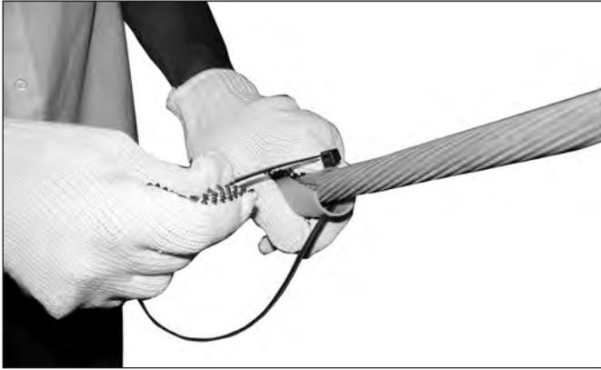
**3.** Aplique a abraçadeira plástica com a parte serrilhada voltada para o lado de dentro, passando pelos furos do Sinalizador e, então, introduza a extremidade da abraçadeira na trava.
