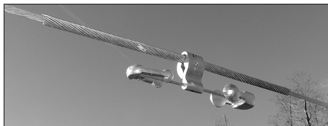
Figura 9: Amortiguador completamente instalado sobre Varillas de Protección.
