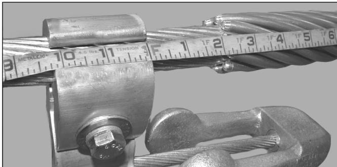
Figura 4.2b: Posicionado del primer amortiguador, 50 mm. (2 pulgadas) a partir del extremo de las varillas de protección.
