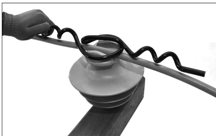
1. Posicione o centro do Laço Plástico de Topo sobre o centro do isolador, com ambas as pernas paralelas ao condutor.
