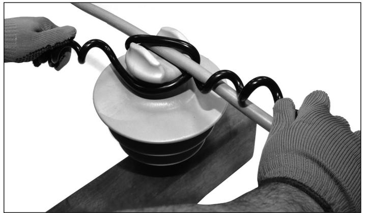
**4.** Inicie a aplicação de uma das pernas do Laço conforme mostrado.
