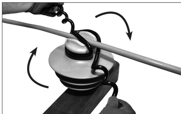
2. Segure o Laço com as duas mãos conforme mostrado. Pressione levemente para baixo e gire no sentido horário de tal maneira que ambas as pernas passem por baixo do condutor.
