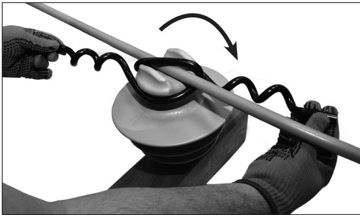
**3.** Continue girando o Laço Plástico no sentido horário em torno e abaixo do pescoço do isolador até que as pernas do Laço estejam novamente paralelas ao condutor. Neste ponto o Laço se encaixará no pescoço do isolador.
