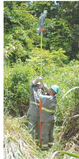
Cavalcante & Luigi. Os resultados das instalações foram satisfatórios, não ocorrendo qualquer problema, mesmo com a rede energizada. Nos três locais, foram instalados cerca de trinta espaçadores.
