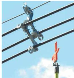
Finalmente, no dia 24 de março, em Atibaia - SP, nossa equipe foi acompanhar a instalação dos Espaçadores de 15 kV com vara telescópica em uma rede compacta da Elektro, com mais de 15 anos de construção.
