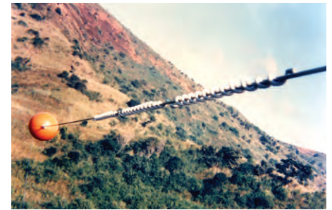
SVDs instalados em série
