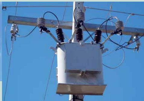
Por intermédio do projeto de P&D com a ANEEL e parceria com as empresas AES Sul e LAT-EFEI de Itajubá-MG, a PLP Brasil desenvolveu o Para-raios Polimérico de 5 kA para redes de distribuição de energia elétrica.
